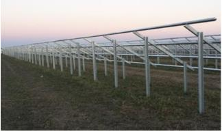
Figura 3-10 - Messa in opera delle strutture di sostegno
