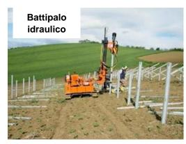
Figura 5-1 – Esempio di posa delle strutture portanti.
